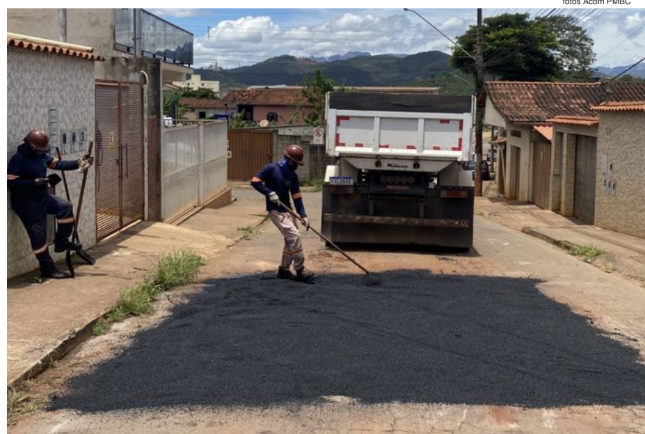
Empresa contratada está corrigindo também a área de entorno dos buracos
